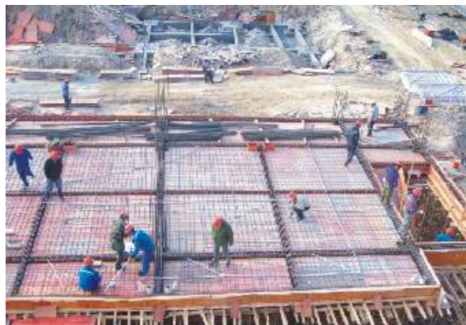
综合楼和配电房浇筑
