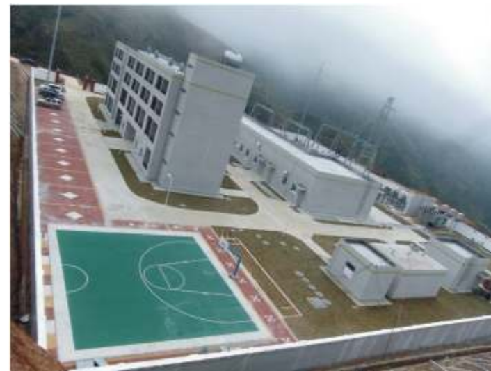
竣工后的变电站
