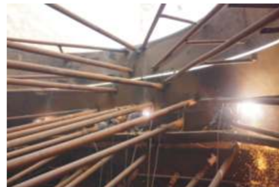
在狭小的空间施工
