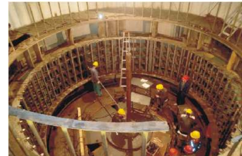
定子改造施工
