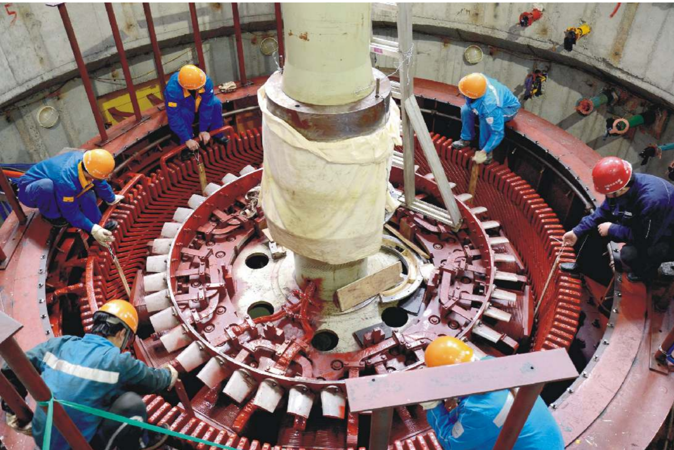
机组转子检修后吊装就位
