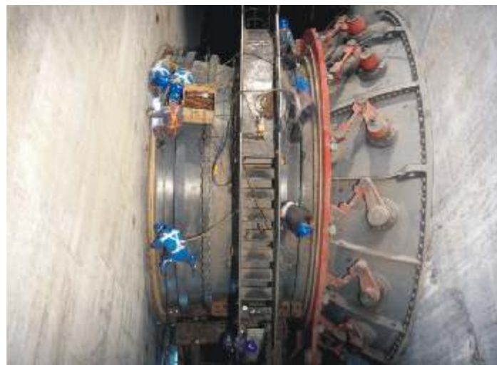
贯流式机组检修
